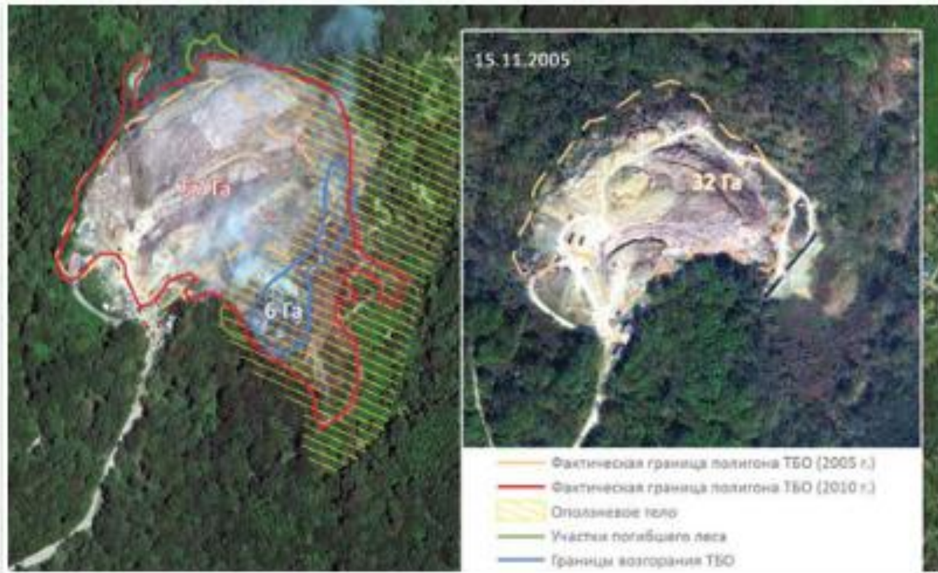
Мониторинг состояния полигона твердых бытовых отходов п. Лoo
