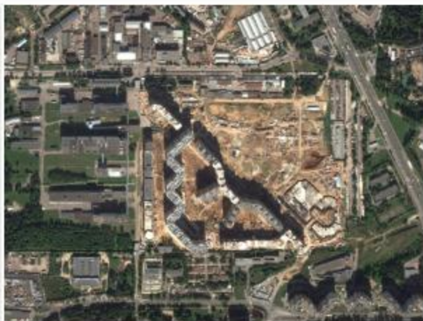
Завершено строительство первого дома, на завершающей стадии - второй дом и паркинг, ведутся работы еще на 4 объектах, готовится котлован
