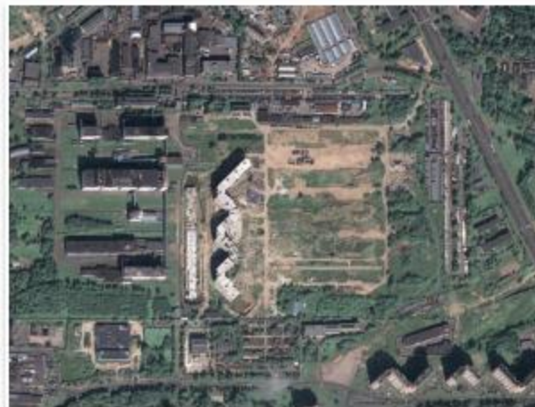
Завершен снос объектов, возводится первый многоэтажный дом (около 70% основных работ), начато строительство паркинга (слева)
